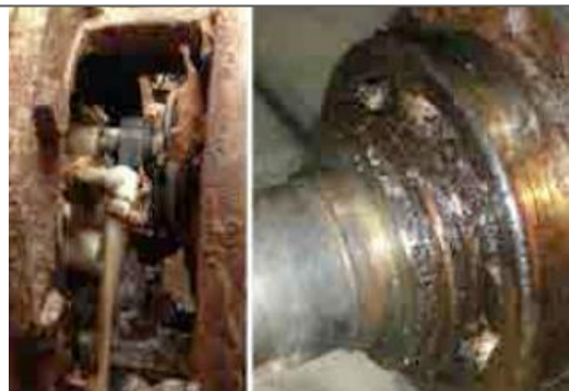
Los rodamientos fallan frecuentemente en las bombas de lodos.
