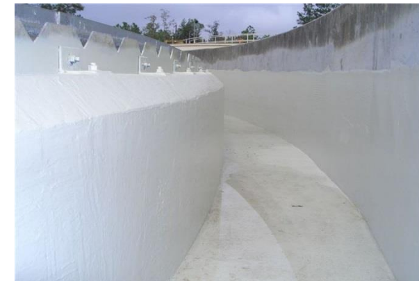
Después: Acabado final del recubrimiento aplicado
