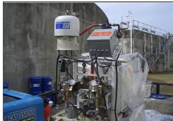
En proceso – Aplicando S1HB con Air-less de componentes plures
