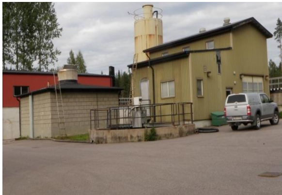
Antes – Ubicación del pozo húmedo
