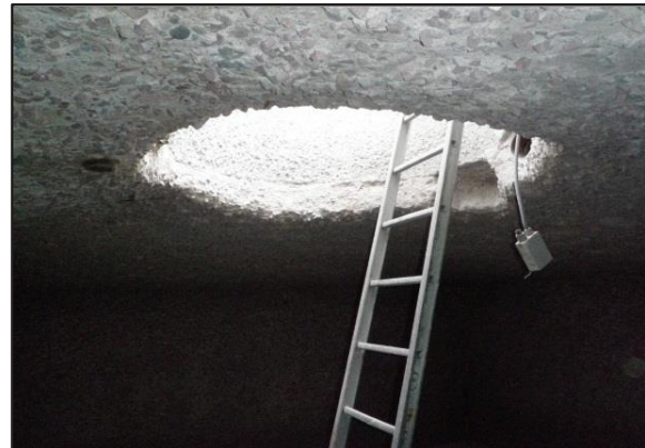
En Proceso – Superficie del pozo después de limpieza con agua y arenado.
