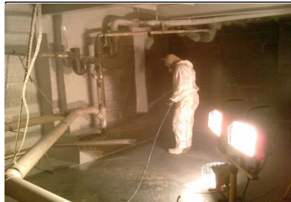
En proceso – Aplicando S1HB con Air-less de componentes plurales
