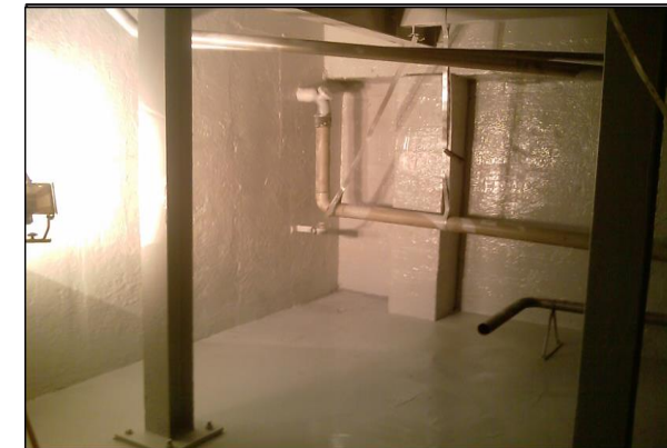
Después: Acabado final del recubrimiento aplicado
