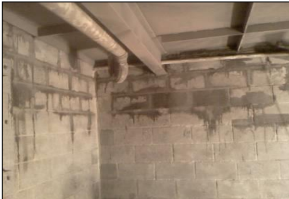
Antes–Limpieza con agua y parcheo con mortero
