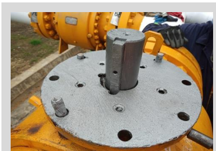
Mantenimiento al mecanismo del actuador / limpieza y lubricación de sus componentes para la corrección de anomalías. .
