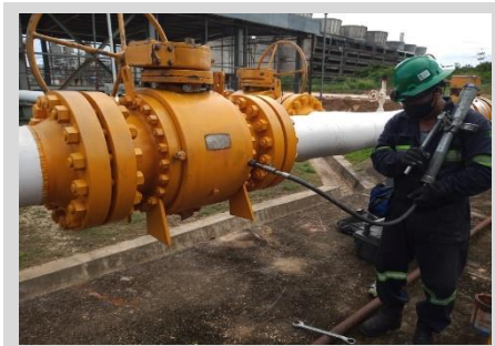
Inyección de grasa sellante a los anillos interno.
