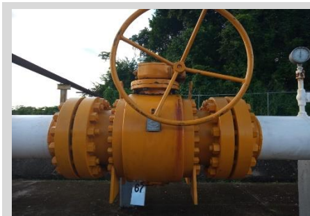
Válvula de 10"600# de esfera con problemas de operabilidad y hermeticidad
