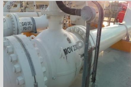
Los posibles puntos de fuga en la válvula son por los accesorios de graseras y alimentador de empaque plástico a la caja de sello de vástago y accesorios.
