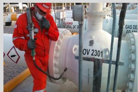
Inyección de desincrustante para limpieza de las venas de lubricación, Inyección de grasa sellante a los anillos y empaque plástico a la caja de sello de vástago para evitar emisiones a la atmósfera
