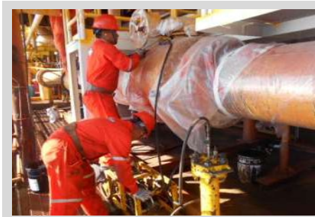
Instalación de equipo de alto volumen e inspección de condiciones de la válvula.
