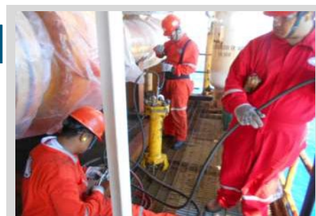
Preparación del equipo de inyección de alto volumen para el sellado inverso de la válvula de 24"600# Marca Walworth.
