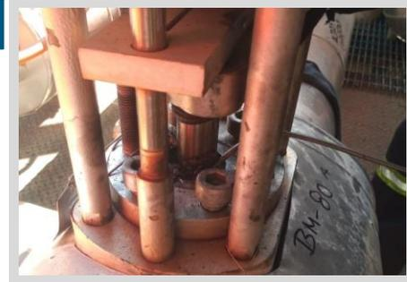
Válvula Globo de 1" 1500# con problemas de empaquetadura por el deterioro.
