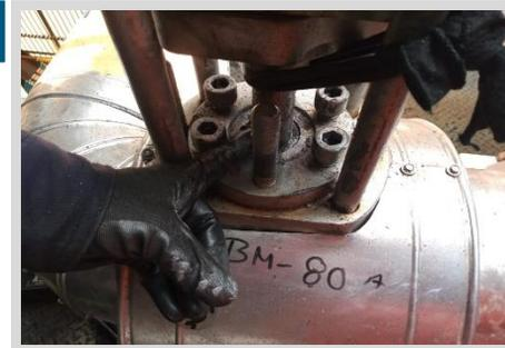
Instalación de OSV en la caja de estopero de la válvula para corregir dicha anomalía.
