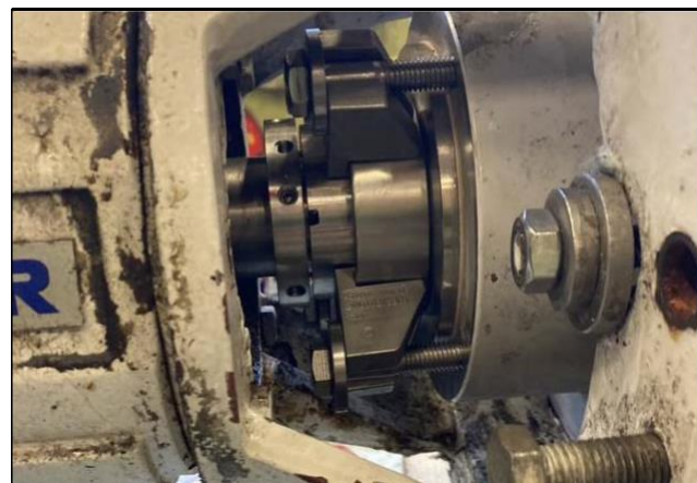
1510 instalado con monitor Chesterton Connect
