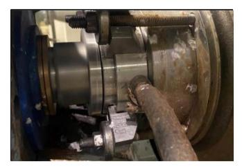
1510 instalado en bomba centrífuga Scanpump.
