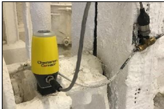
Chesterton Connect acoplado a la bomba de lodo.
