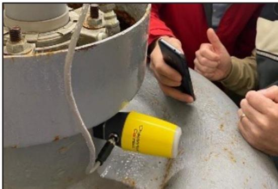
Sensor Chesterton Connect instalado en la bomba.
